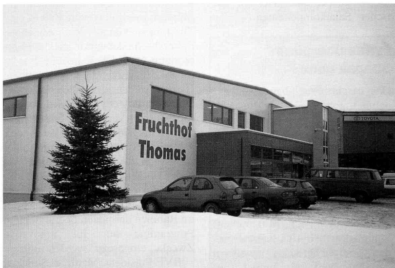
Der neue Fruchthof Thomas GbR in Dresden-Lockwitz. Das vollklimatisierte Produktions- und Logistikzentrum mit einer Grundfläche von 2.200 m 2 enthält u. a. drei Kühlzellen mit insgesamt 300 m 2 Standfläche.
