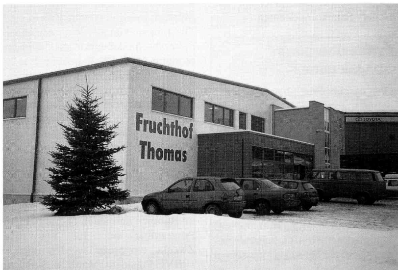
Der neue Fruchthof Thomas GbR in Dresden-Lockwitz. Das vollklimatisierte Produktions- und Logistikzentrum mit einer Grundfläche von 2.200 m 2 enthält u. a. drei Kühlzellen mit insgesamt 300 m 2 Standfläche.
